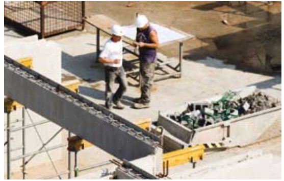
Fig. 57 : Tri des déchets sur chantier propre (arch. WIT / Bogdan & Van Broeck / LAVA, photo André Nullens)
