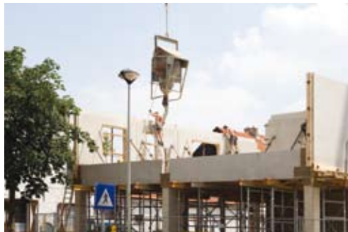
Fig.54-55 : Pose d'élément préfabriqué et coulage de béton prêt à l'emploi (arch. WIT / Bogdan & Van Broeck / LAVA, photos André Nullens)
