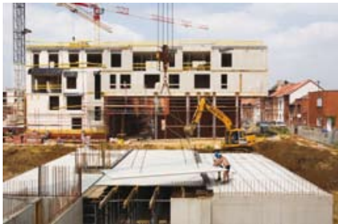
Fig.54-55 : Pose d'élément préfabriqué et coulage de béton prêt à l'emploi (arch. WIT / Bogdan & Van Broeck / LAVA, photos André Nullens)
