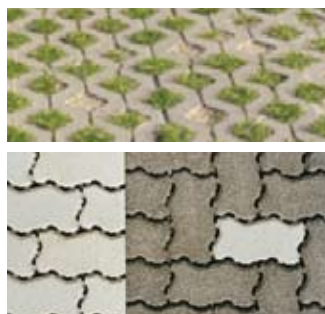
Fig. 49 : Dalles gazon et pavages drainants
