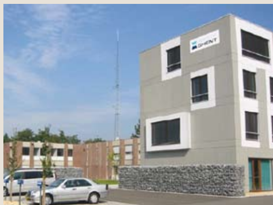
Fig. 63 : Siège du 'Havenbedrijf Gent' – Vue d'ensemble
